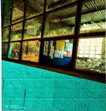
Foto 1: SUSTITUCION DE VIDRIOS
