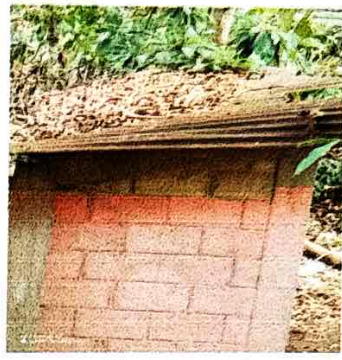
Foto 2: SUSTITUCION DE LAMINAS PARA SANITARIO
