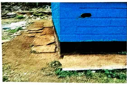
Foto 5: REPARACION DE BANQUETA
