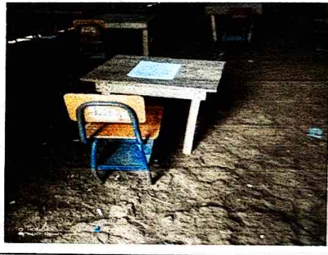
Foto 4: SUSTITUCION DE PISO
